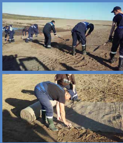
Рисунок 4. Укладка биомата ООО «Газпром добыча Надым»
